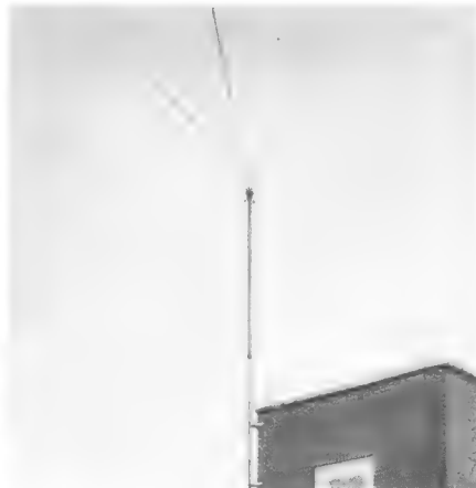
Bild 4. Die Sendeantenne am Turm des Verwaltungsgebäudes
